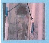
Encontraremos dos llaves de paso es importante que las dos se abran permite el paso del agua de la cisterna y si llega el agua permite la entrada de acueducto.
